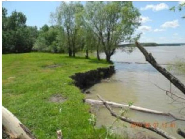
а) разрушенный участок берегозащитного сооружения постройки 80-х годов; б) промоина в гребне берегозащитного банкета постройки 2011 г справа – р. Обь, слева – пойменное озеро; в) «карман размыва» на верхнем фланге берегозащитного сооружения; г) неукрепленный участок берега между верхним флангом сооружения и устьем протоки Ереснинской.
