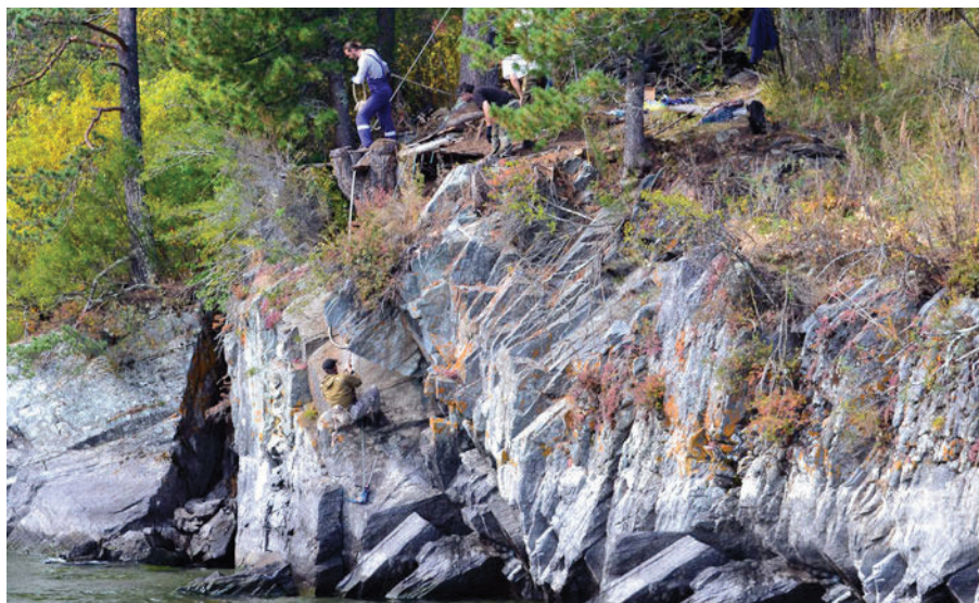
Установка датчиков колебания уровня воды.
