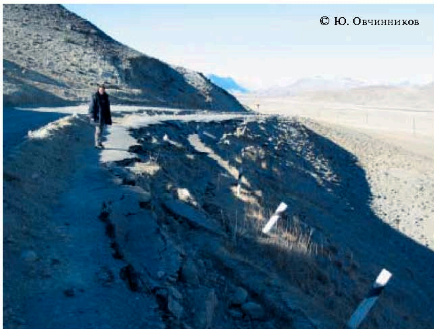
Разрушение дорожного полотна в эпицентре землетрясения
