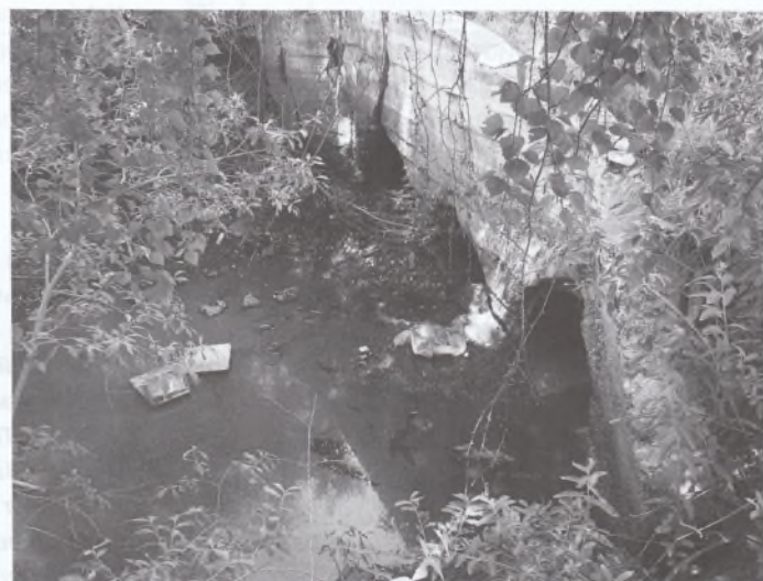
Рис. 4. Мостовой переход на Кожурлинском канале
